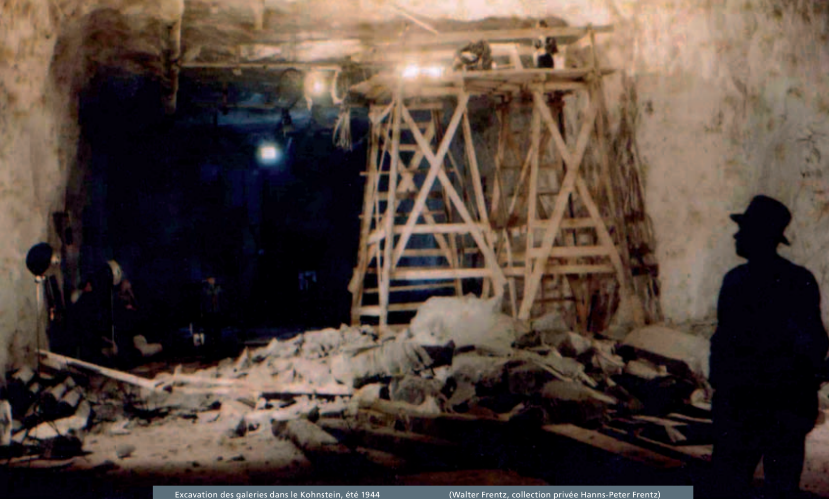
Excavation des galeries dans le Kohnstein, été 1944
