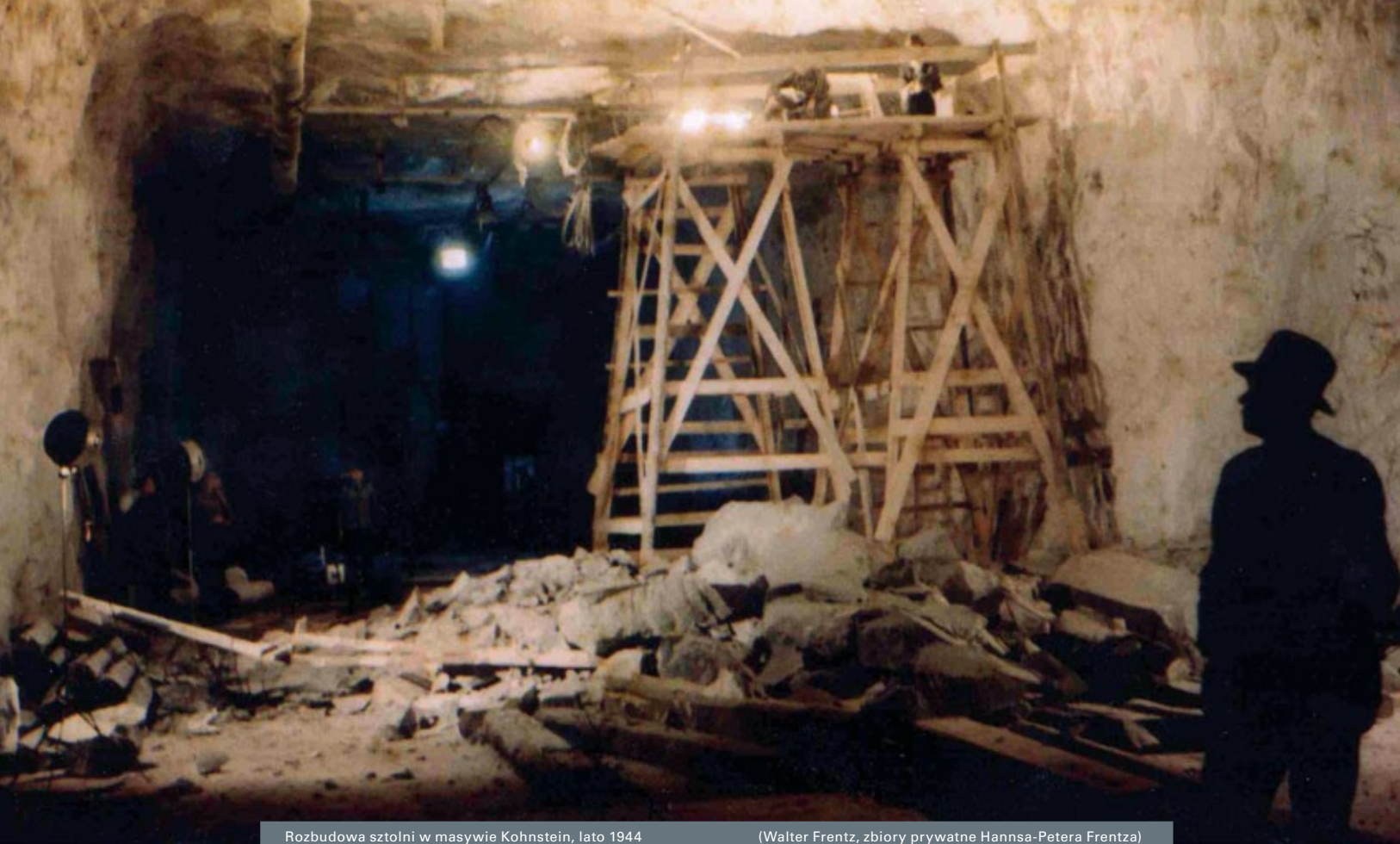
Rozbudowa sztolni w masywie Kohnstein, lato 1944
