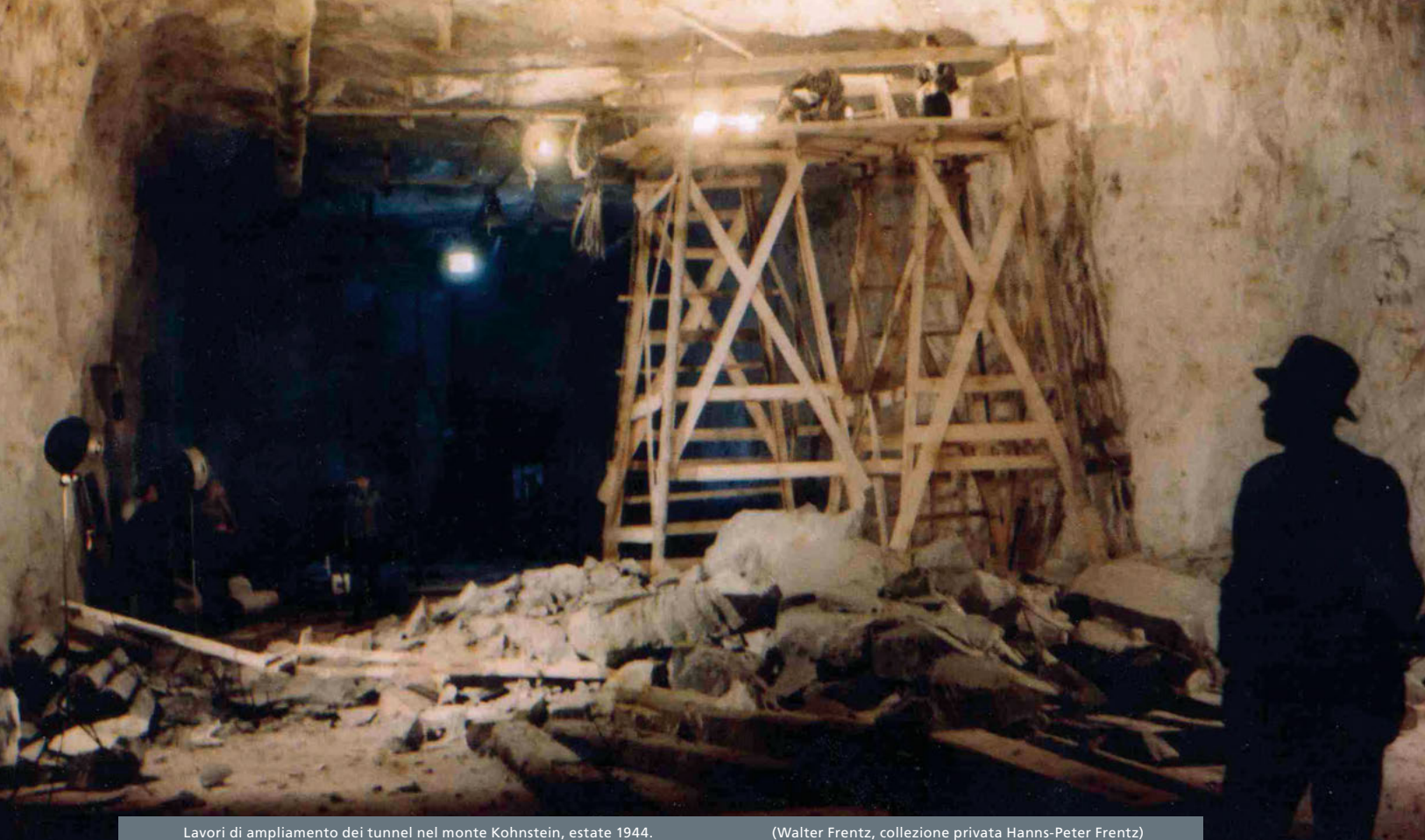
Lavori di ampliamento dei tunnel nel monte Kohnstein, estate 1944.
